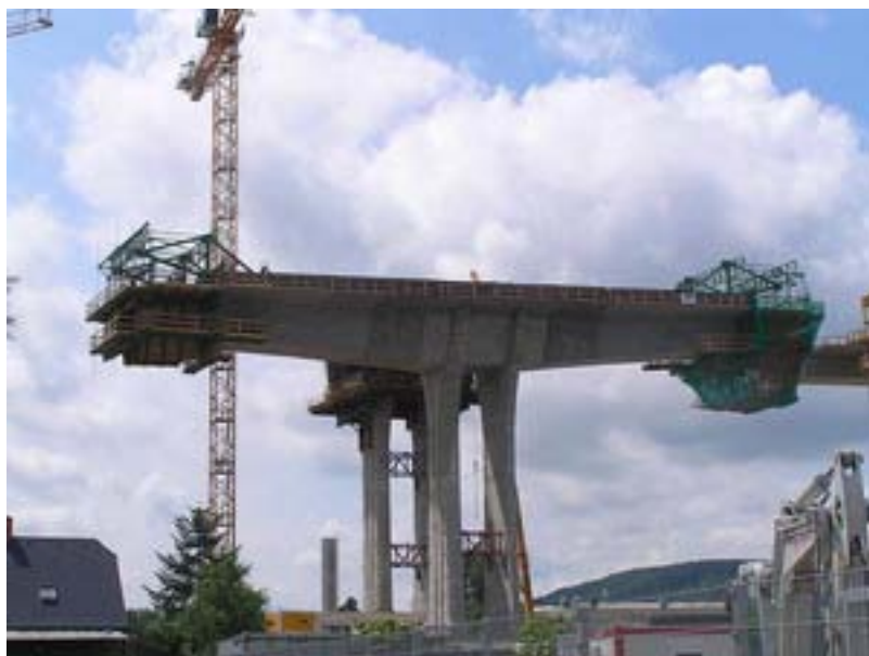
Obrázek 107 21 – Postup výstavby pomocí betonovacího vozíku
