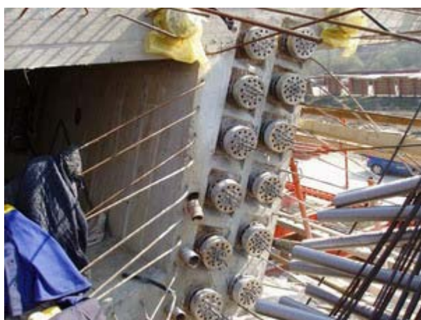
Obrázek 71 12 – Předpínací lana před spojením
