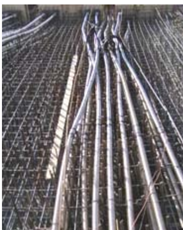
Obrázek 59 6 – Příklad realizace vedení kabelů mezi betonářskou výztuží
