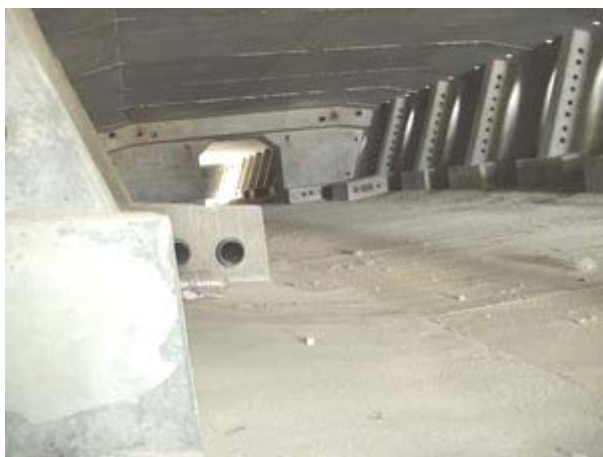
Obrázek 60 7 – Deviátory v komorovém průřezu
